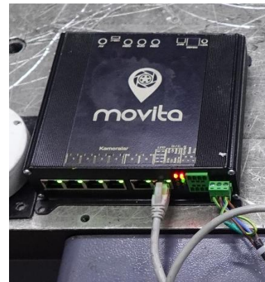
FOTOĞRAF 5.18. Tüm Testler Sonrası Fonksiyonel Kontrol PICTURE 5.18. Functional Check After All Test
